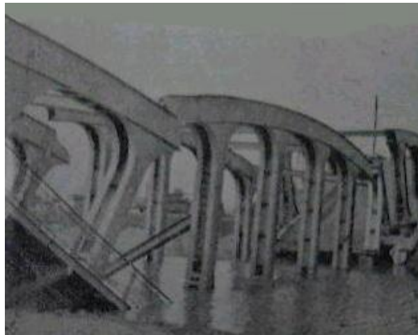
2. 1938年 溶接道路橋の崩壊 (ベルギー)
