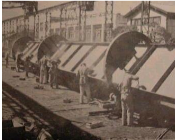
11. 1953年 橋桁での溶接作業(日)
