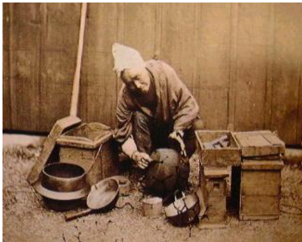
1. 明治期 ろう付での補修作業 (日)
